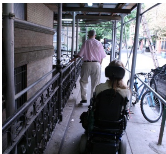
Foto 37: Área de circulación que mantiene condiciones accesibles durante los trabajos.
