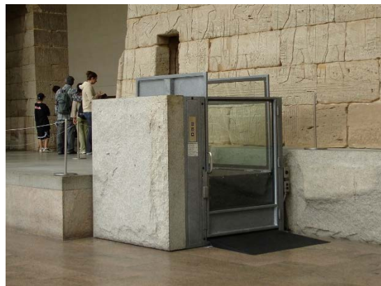
Fig. 61: Plataforma vertical, equipo para salvar desniveles en la ruta accesible de los edificios previos a 2016 Foto 63: Plataforma elevadora vertical para salvar desniveles en edificios existentes. Máximo 1,5m de desnivel.
