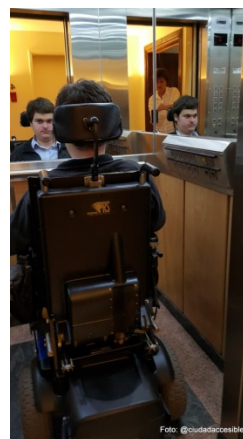
Foto 59: Ascensor con espejo ubicado sobre el pasamanos.
