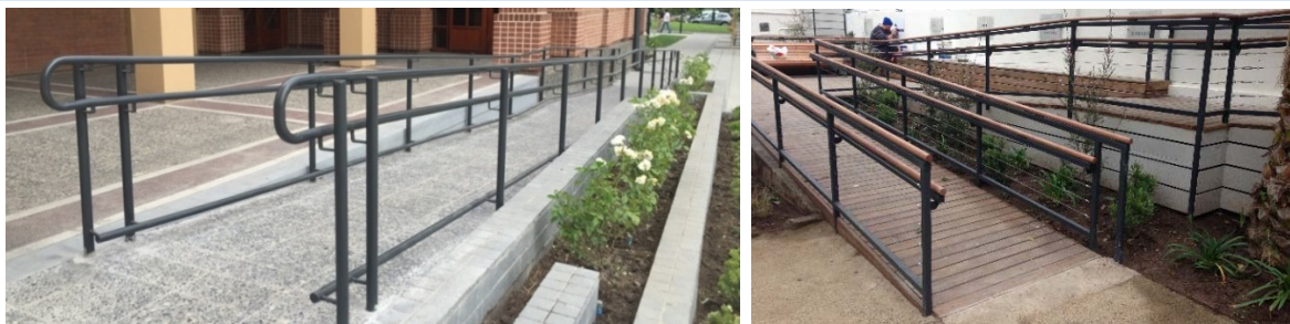
Fotos 53 y 54: Rampa con pasamanos a doble altura. Ambos pasamanos deben ser continuos, de manera que el deslizamiento de la mano no se interrumpa en todo el trayecto.
