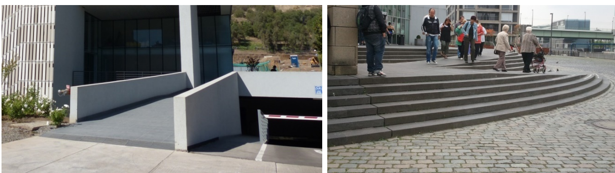
Foto 56 (izq): Los planos inclinados de pendiente igual o inferior a 5% están exentos de los requisitos de rampa. Foto 57 (der): Las rampas combinadas con escaleras deben responder a planos inclinados con pendientes igual o menor a 5% para evitar la obligación de pasamanos.
