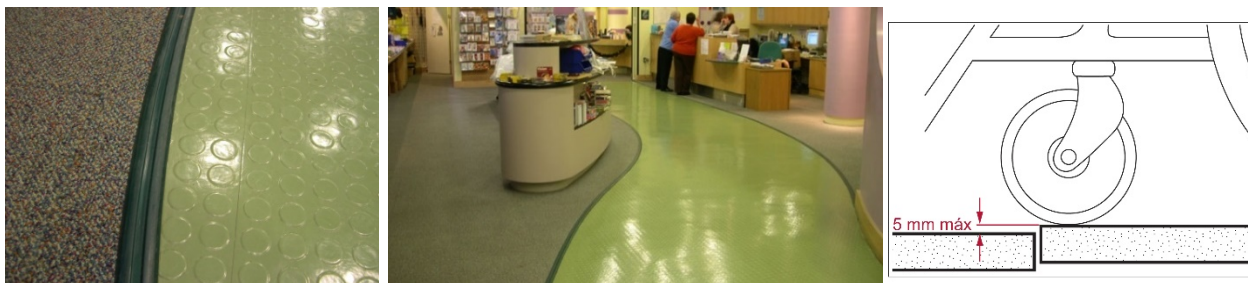
Foto 48 y 49: Alfombra y piso vinílico firmemente adheridos y unidos. (Fotos: Ximena Rosello) Fig 47: Desnivel máximo entre juntas de piso terminado.
