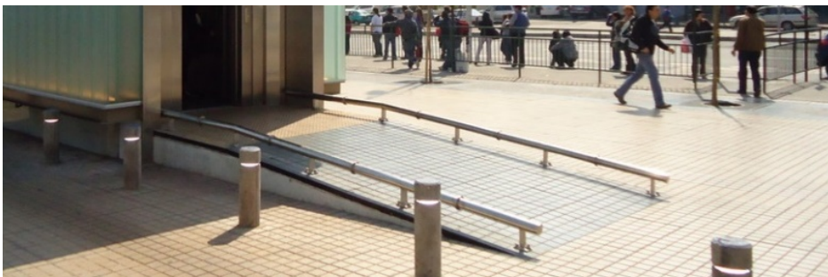
Foto 55: Rampa con protección lateral.
